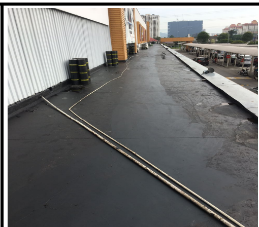
Photo 3 Touch up of bitumen primer
